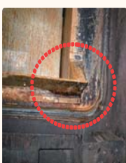
汚水パッキン劣化変形
